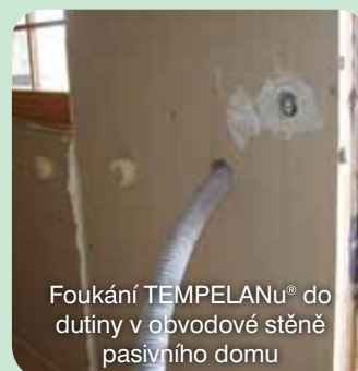
Foukání TEMPELANu ® do svislé dutiny obvodové stěny pasivního domu
